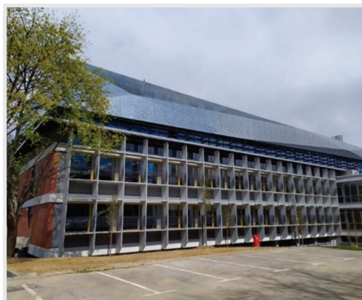
CALT zgrada nakon završetka projekta koja je ujedno i prvo krilo Instituta za fiziku.
